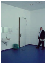
а) попередній стан приміщення, проста функціональна кімната
