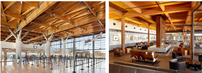
Рис. 3. Конструкції дерев'яної покрівлі Portland Jetport Airport та Jackson Hole Airport ( https://www.thinkwood.com , https://www.archdaily.com )
