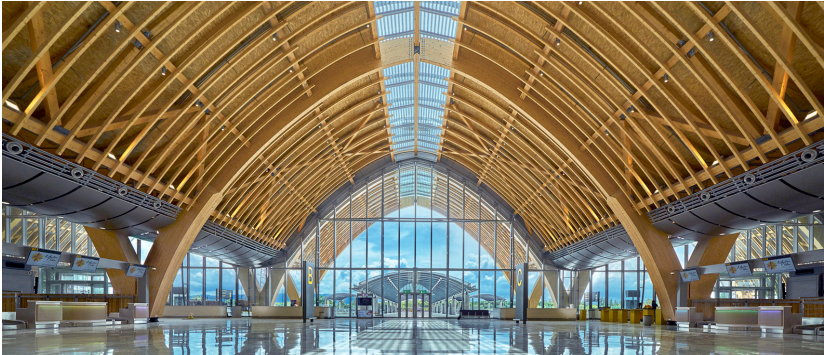
Рис. 2. Термінал аеропорту Мactан Cebu ( https://www.archdaily.com )
